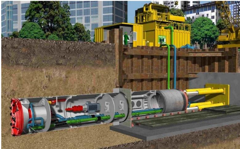
Si è optato per predisporre la camera di spinta a valle dell'attraversamento, poiché la zona è più facilmente raggiungibile dalla strada provinciale SP 31 bis, sia per il trasporto delle attrezzature (macchina per jet-grouting, macchina per l'infissione delle palancole e testa fresante microtunnelling con relative cabine di comando e vasca miscelazione fanghi bentonici), sia per la consegna delle tubazioni in c.a. (n. 150 tubi complessivamente).
