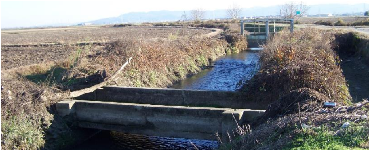
FOTO A: Paratoie sulla Roggia Cerca, tratto iniziale dell'intervento in progetto, ai margini esterni della Riserva Naturale delle Paludi di San Genuario.
