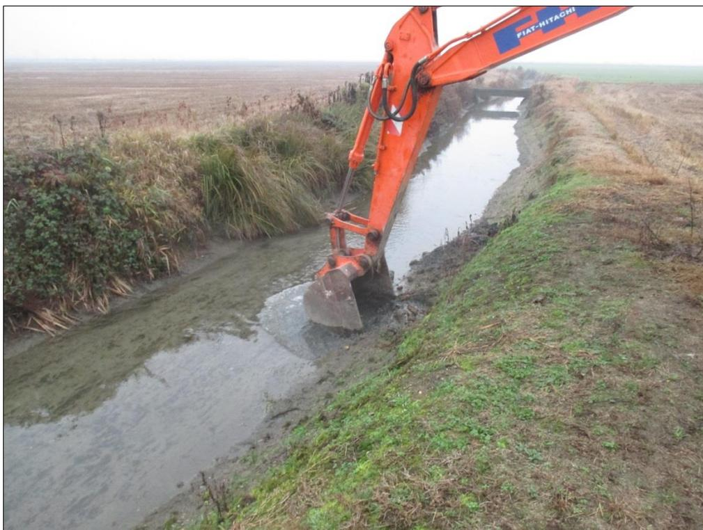
**Figura 2 -** Prelievo di materiale con escavatore nel letto del canale che, adeguatamente ampliato, andrà a costituire il nuovo scolmatore (21/11/2016 - pozzetto esplorativo pexp1).
