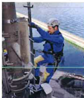
Regola 7 Usare le scale anticaduta in sicurezza
