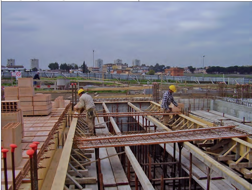
Sottoponte parziale per realizzazione solaio
