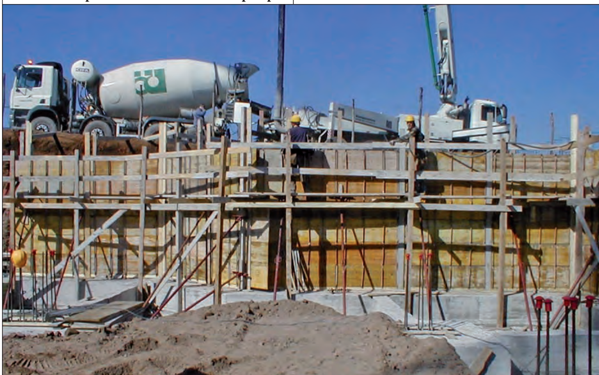
Getto di una parete con autobotte e autopompa
