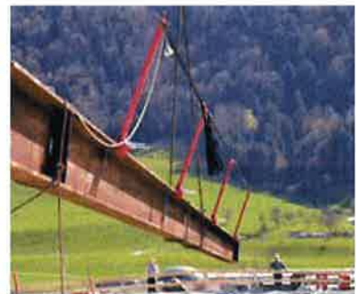
3 Limitare il più possibile i lavori con i DPI anticaduta effettuando il premontaggio a terra.
