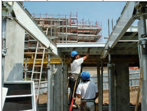
Montaggio carpenteria modulare
