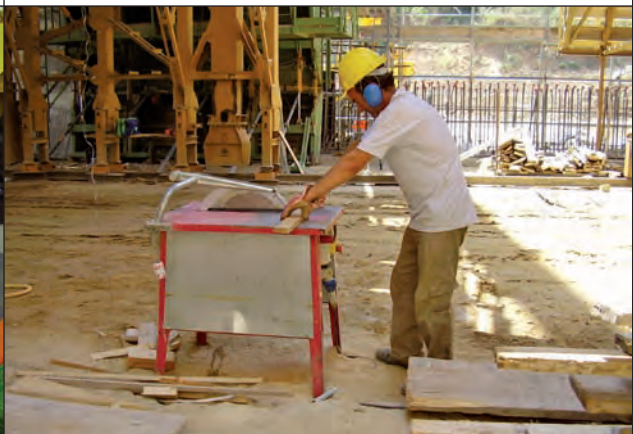
Lavoro alla sega con D.P.I.
