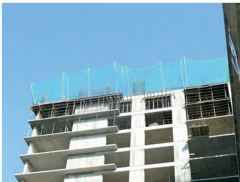
Figura 5.2.2-4 Sistema V: rete di sicurezza fissata ad un sostegno di tipo a forca
