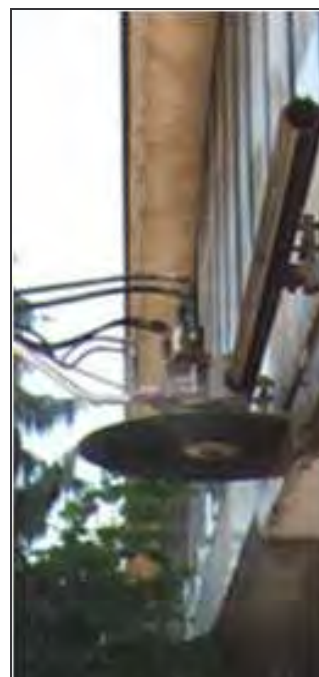
Foto 2 - Sega da parete con disco diamantato posizionata per eseguire un taglio orizzontale (Fonte: http://www.conci.it )
