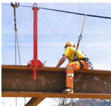
2 Linea vita temporanea con montanti per un dispositivo di ancoraggio continuo.
