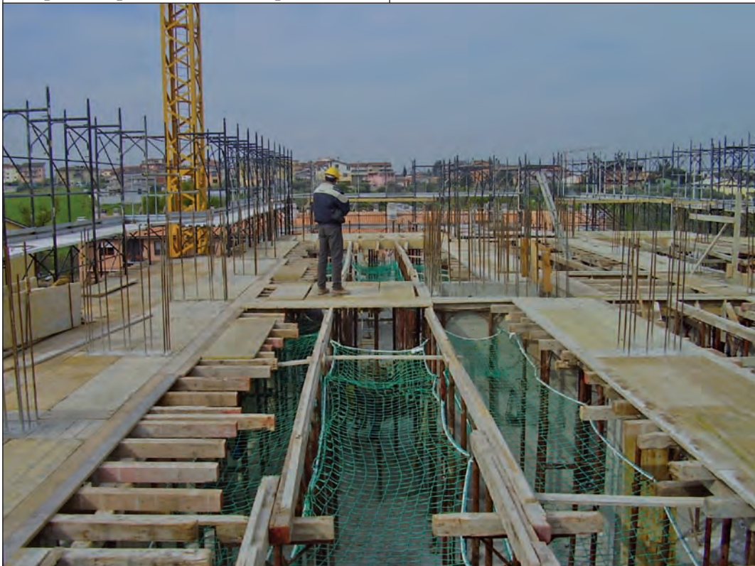
Carpenteria parziale con reti di protezione
