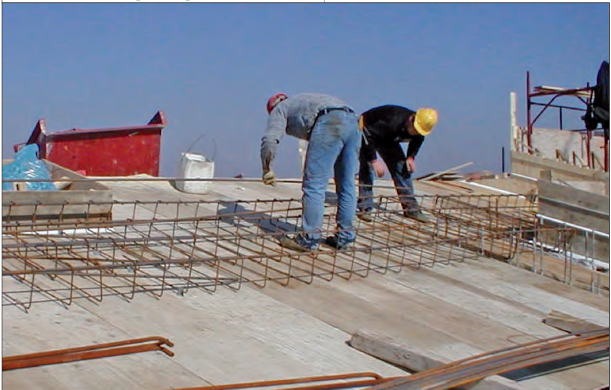
Posa del ferro sulla carpenteria piena di un tetto a falde
