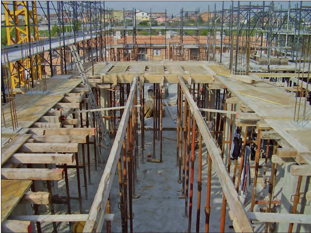
Carpenteria parziale prima del montaggio delle reti di protezione
