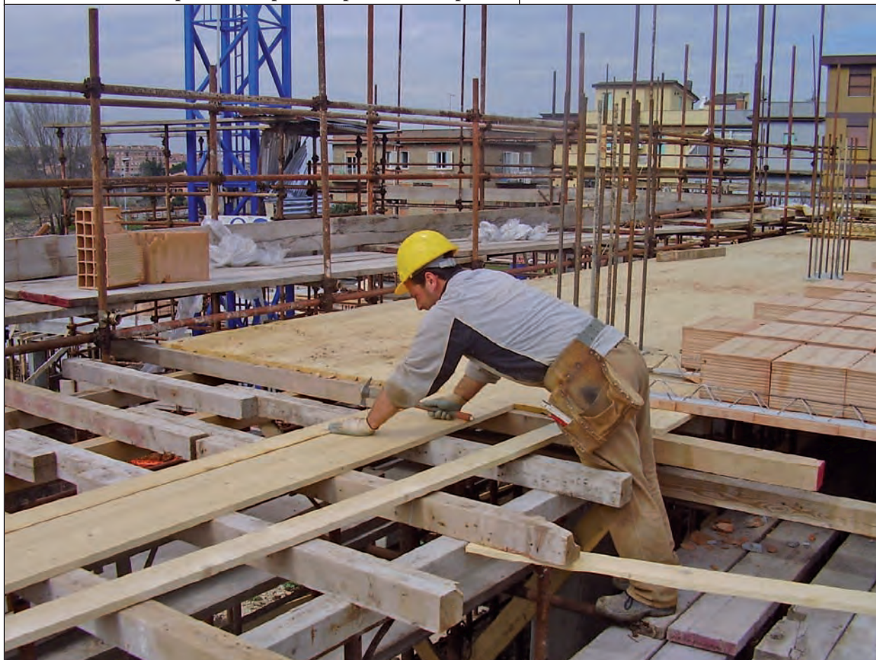
Realizzazione di un piano di carpenteria piena da sottoponte
