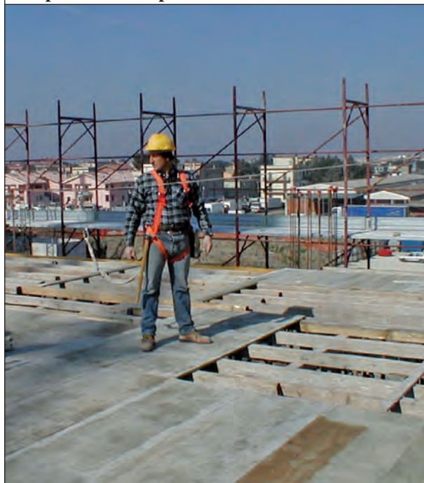
Carpenteria da sopra: lavoratore con imbracatura
