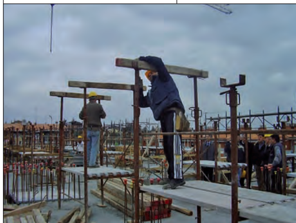
Sistemazione delle traverse
