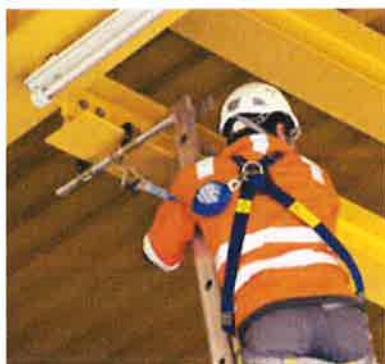
1 Sistema temporaneo che serve da punto di ancoraggio sulle travi di acciaio.
