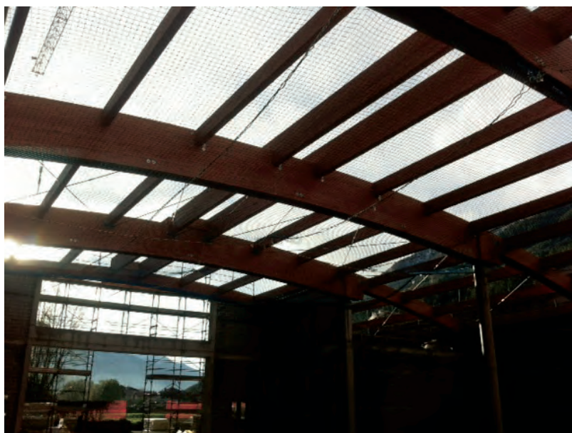
Figura 5.2.1-1 Esempio di sistema S: copertura in legno
