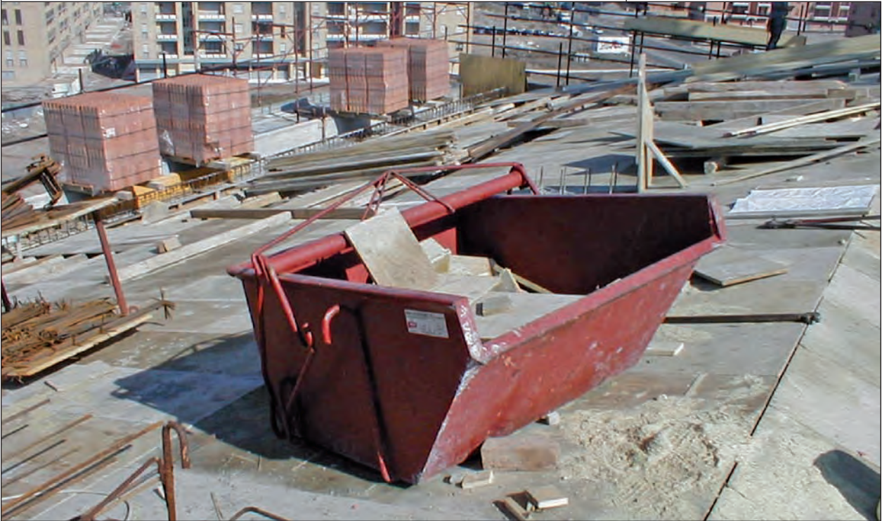
Cassone per il trasporto dei materiali di risulta a ribaltamento automatico
