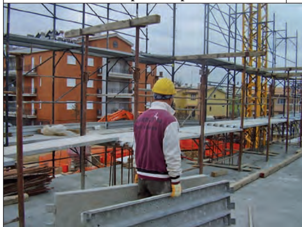
Sistemazione delle traverse
