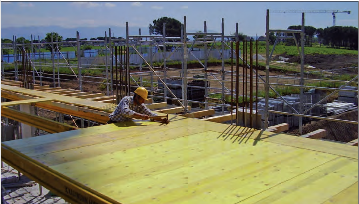
Preparazione piano solaio con carpenteria piena
