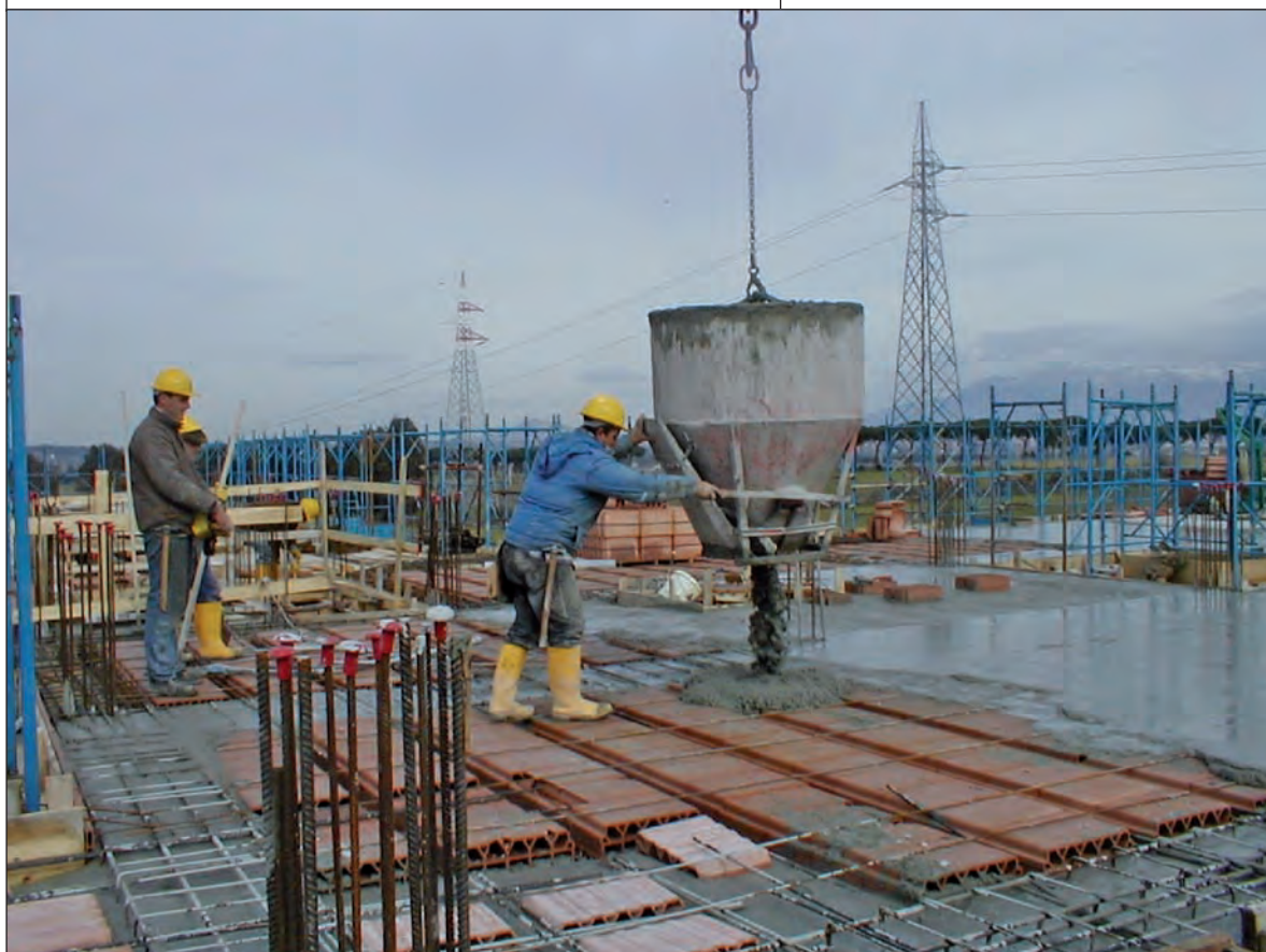
Solaio in latero – cemento. Getto calcestruzzo con secchione
