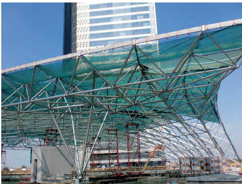
Figura 5.2.1-2 Esempio di sistema S: copertura in acciaio
