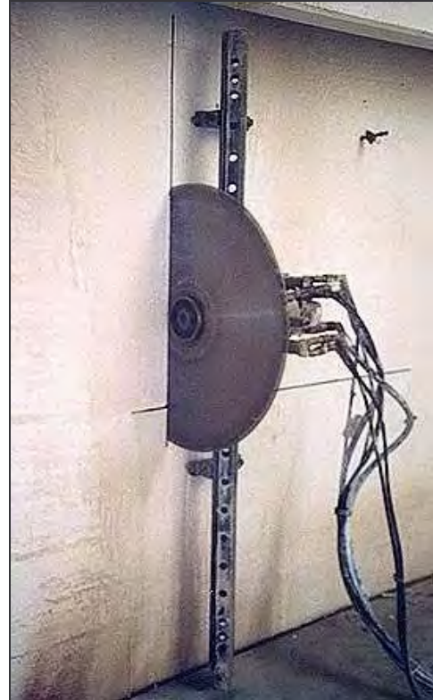
Foto 2 - Sega da parete con disco diamantato posizionata per eseguire un taglio orizzontale (Fonte: http://www.conci.it )
