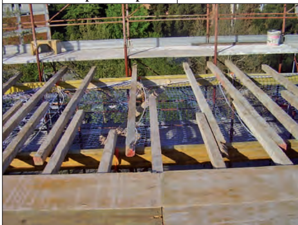
Reti sotto carpenteria piena
