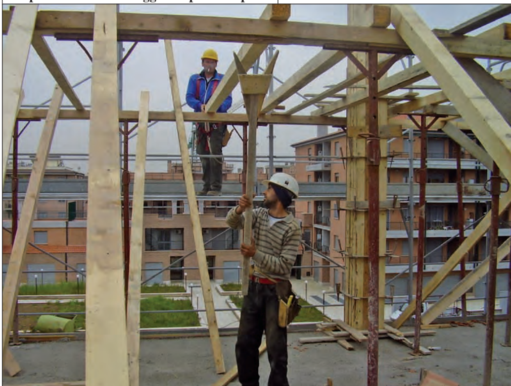
Preparazione banchinaggio carpenteria piena
