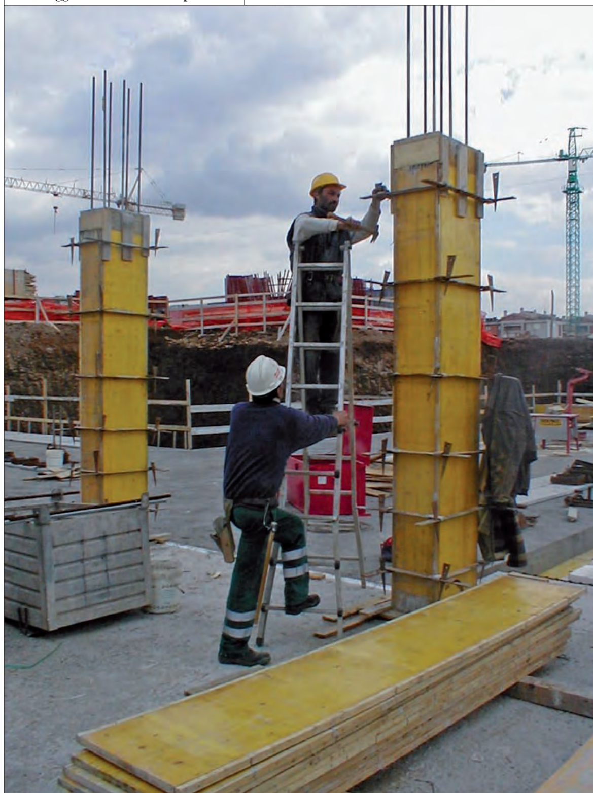
Smontaggio del cassero di un pilastro
