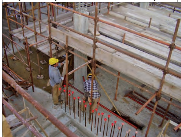
Preparazione puntello da inserire nel sottoponte
