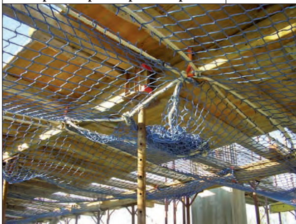
Nodo per reti per carpenteria piena
