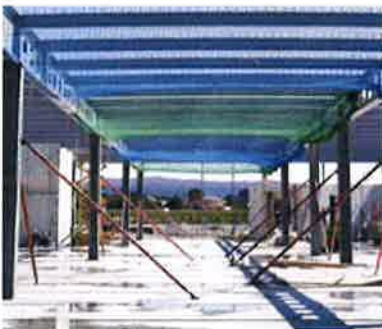
1 Dare la priorità ai dispositivi di protezione collettiva (ad es. reti).
