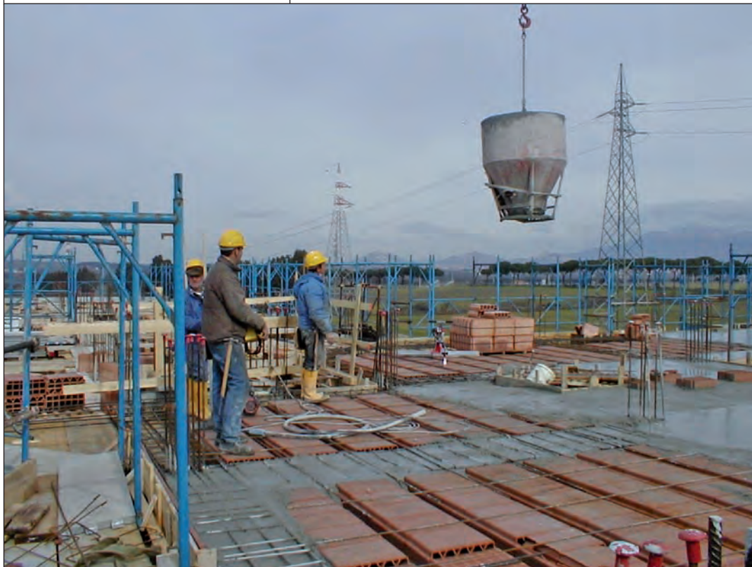
Getto di un solaio con secchione
