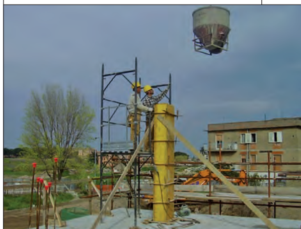
Getto da trabattello formato da elementi di ponteggio
