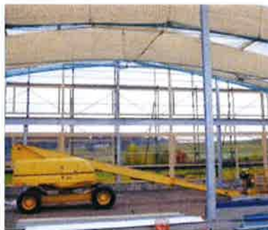
2 Prima di usare i DPI anticaduta verificare la possibilità di utilizzare le piattaforme di lavoro elevabili.
