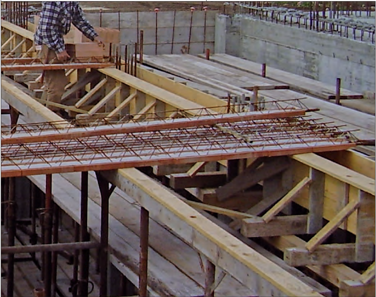
Travetti prefabbricati sulle sponde di una trave ribassata
