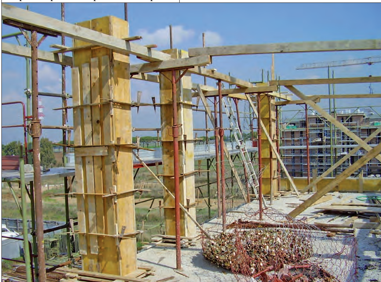
Carpenteria preliminare per i casseri dei pilastri
